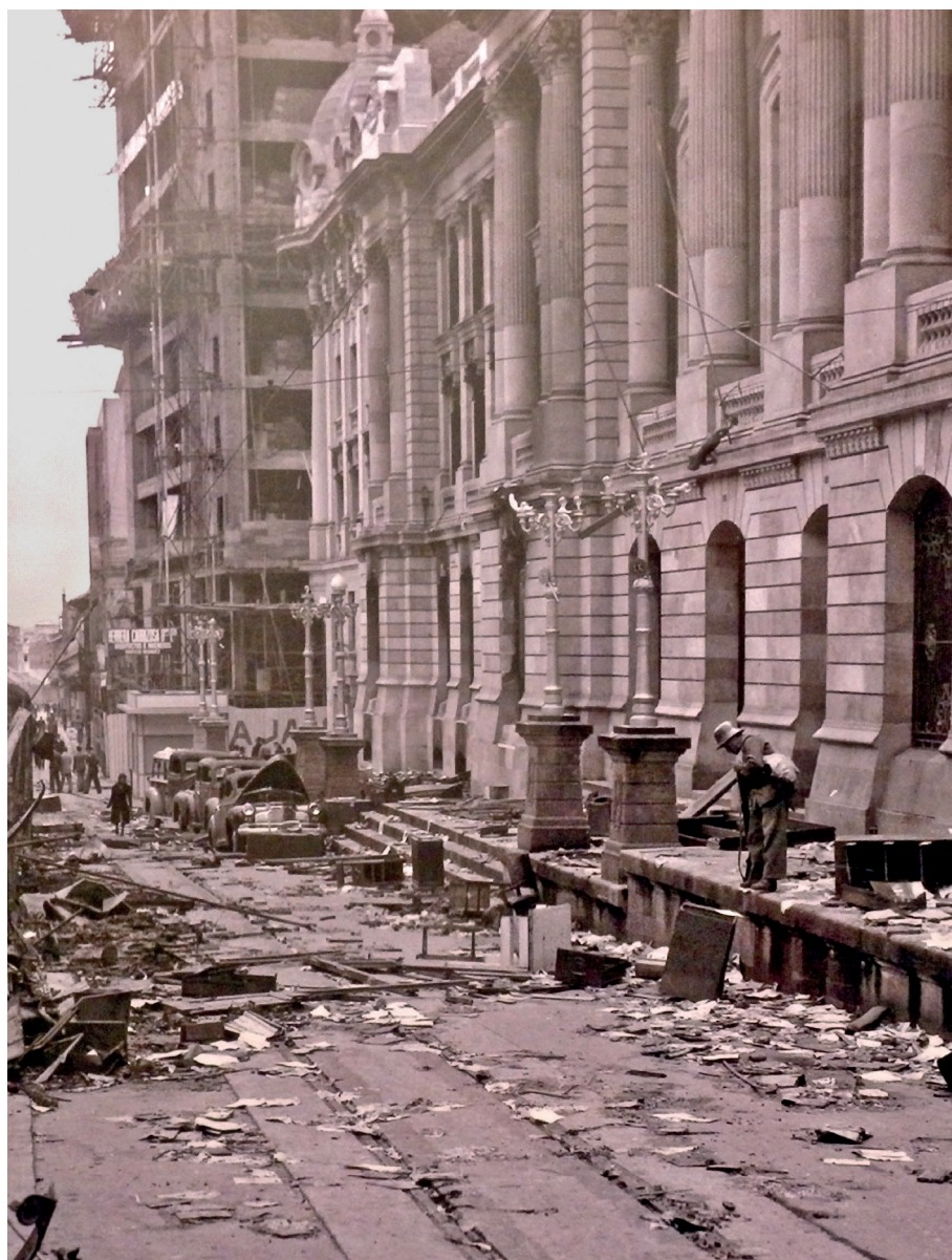
Fig. 2. Bogotá (abril 1948). La antigua Gobernación de Cundinamarca después el “Bogotazo” y las obras de nuevas construcciones, símbolo de la modernización de la capital. Esta imagen ayuda a entender la situación política y social en la época de la llegada de Angiolo Mazzoni a Colombia.
