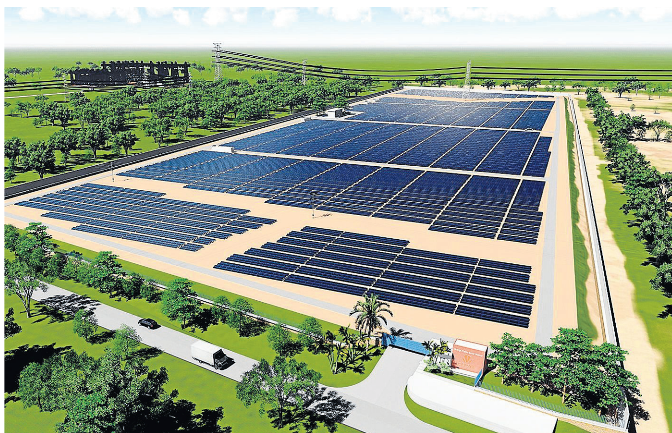
Celsia Solar Bolívar está en el municipio de Santa Rosa de Lima, y contará con cerca de 32 mil módulos. //RENDER: CORTESÍA.
