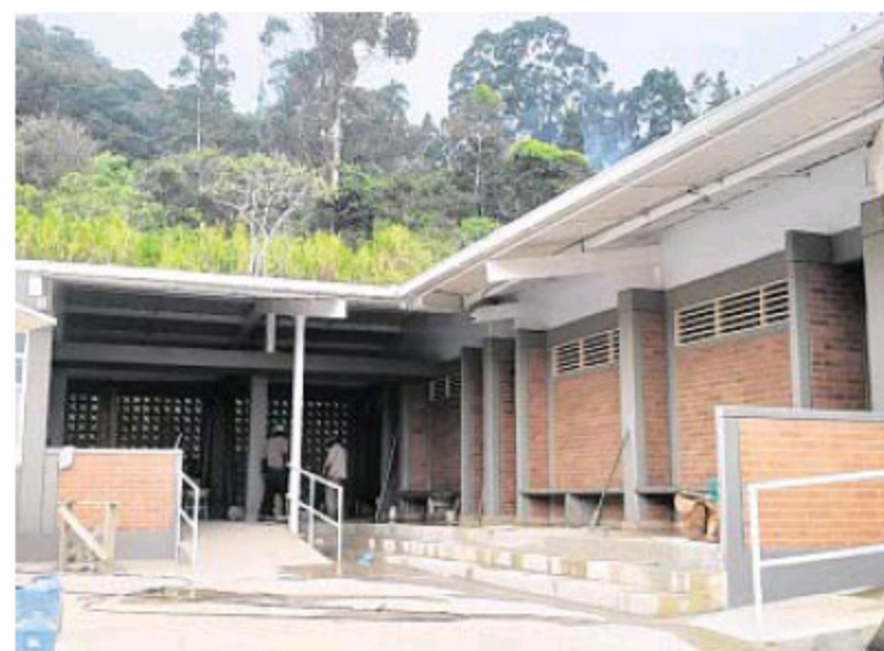
Esta es la nueva sede de la escuela sede La Granja , corregimiento La Castilla, luego de ser reconstruida por la SEM.
