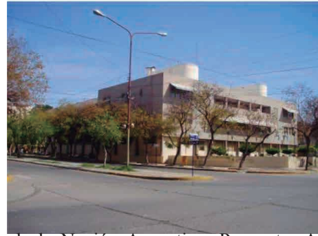
7. Banco de la Nación Argentina. Proyecto: Arquitectos Amaya, Casares, Devoto, Lanusse, Martín y Pieres (1949). Inauguración: 1952.
