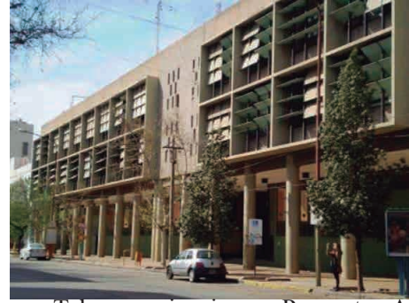
6. Correos y Telecomunicaciones. Proyecto: Arquitectos Agustín Bianchi y E. A. M. Vidal y Francisco Rossi. Dirección de Ingeniería y Arquitectura - Administración Central de Correos y Telecomunicaciones (1952). Inauguración: 1957.
