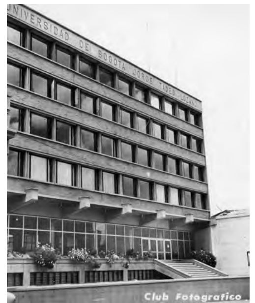
Instalaciones edificio nuevo, 1967
