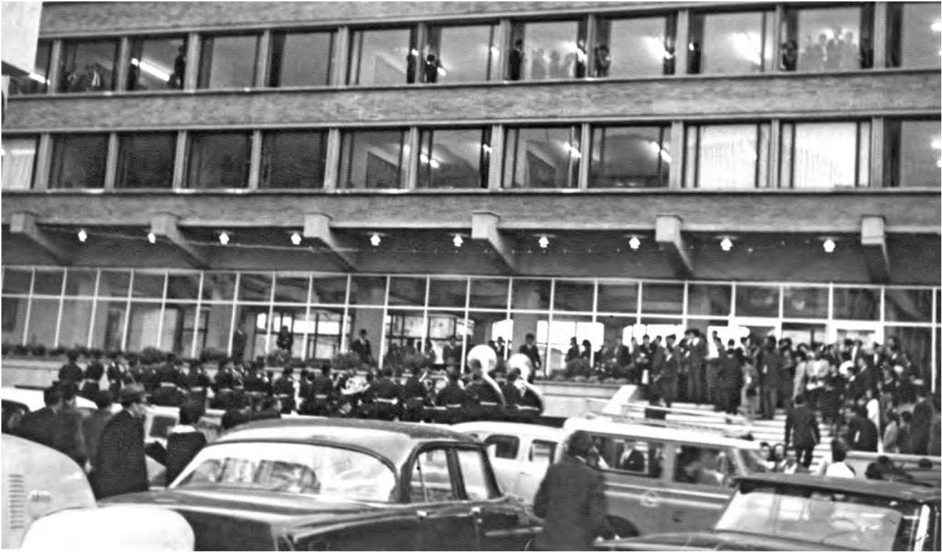
Inauguración en el año 1967 del nuevo edificio, con entrada por la calle 23
