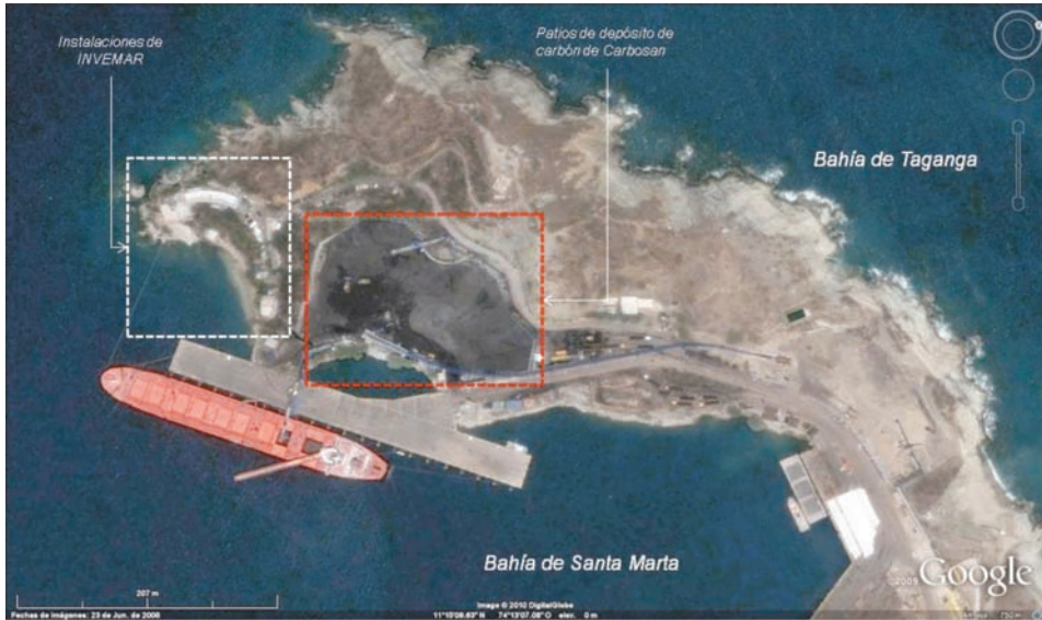
Figura 1.10. Cercanía de los patios de Carbosán (recuadro rojo), con las instalaciones del Instituto de Investigaciones Marinas y Costeras-Invemar (cuadro blanco), en la bahía de Santa Marta, departamento del Magdalena, específicamente en Punta de Betín (tomado y modificado de Google Earth, 2009).
