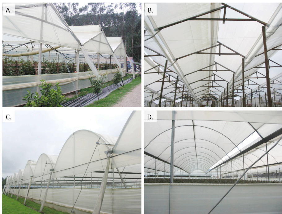
Figura 1. Vista general de un invernadero cenital IC (A y B) y tradicional IT (C y D). En las figuras A (IC) y C (IT) se puede observar la ventilación lateral desde el exterior del invernadero; y en las figuras B (IC) y D (IT) la ventilación cenital desde el interior del invernadero.
