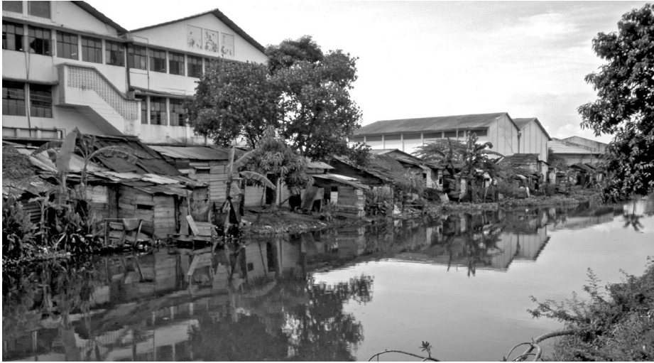
Figura 1.6 Colombo, Sri Lanka, (2006). Alojamiento informal en una reserva del banco del canal (tierra que se mantiene oficialmente libre de obstrucciones para facilitar las operaciones de mantenimiento del canal). (Foto: Patrick Wakely)
