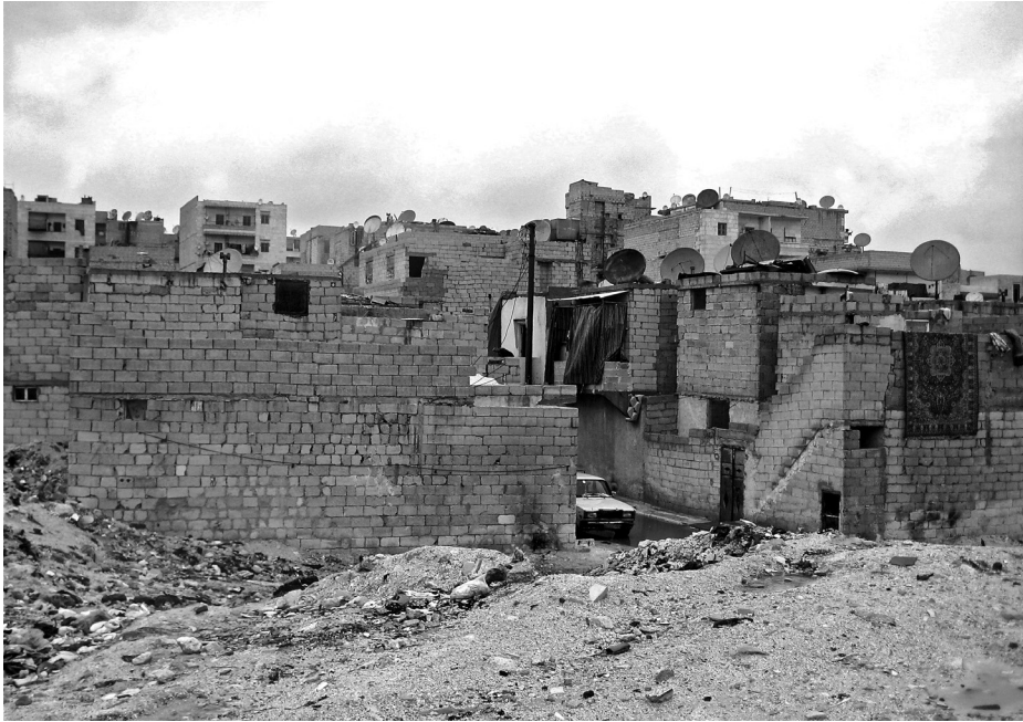
Figura 1.9 Tal al Zarazier, Aleppo, Siria, (2008). Urbanización informal de alta densidad en un basurero abierto no estabilizado en desuso, cerca del centro de la ciudad, con una corriente subterránea que lo atraviesa. La posterior construcción informal en los techos contribuyó al colapso frecuente de edificios enteros, lo que causó lesiones y pérdida de vidas. (Foto: Patrick Wakely)
