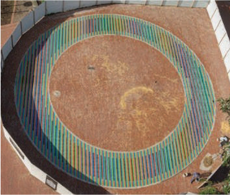
Avance de la obra de intervención.
